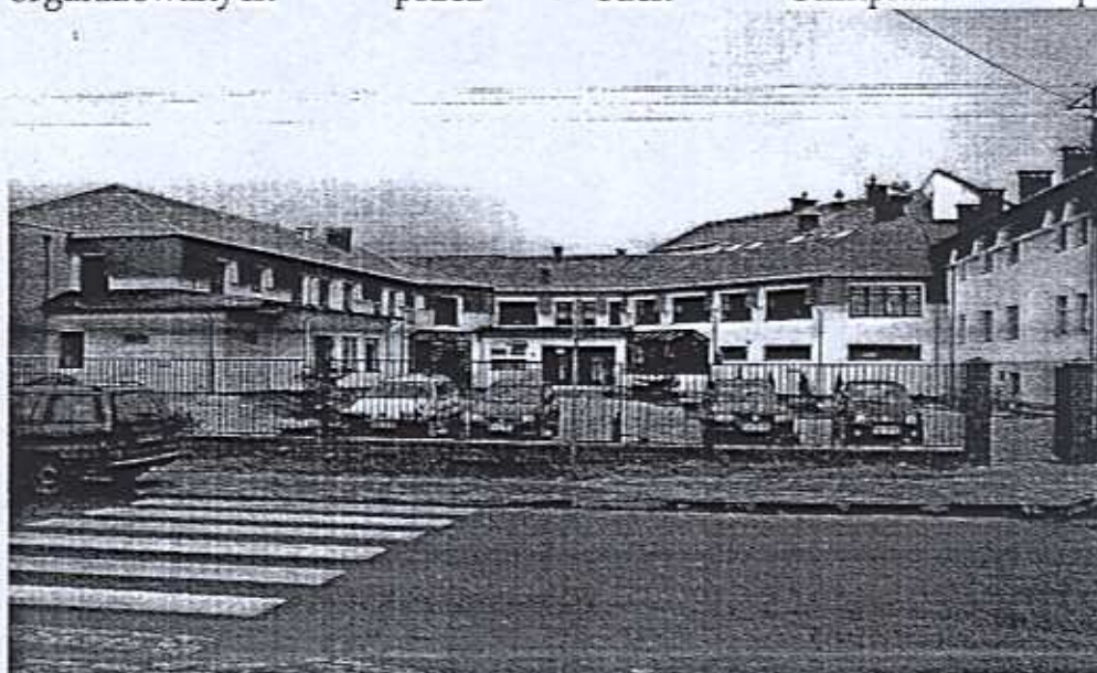
Ryc. 11. Budynek Specjalnego Ośrodka Szkolno-Wychowawczego w Czarni.
